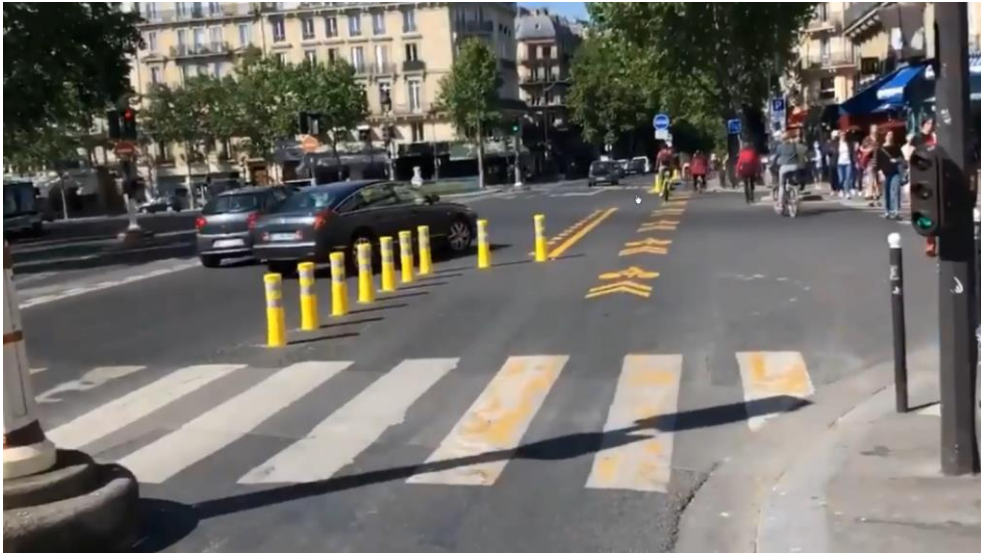
Figur 3-2 Tillfällig korsningsutformning på en pop-up cykelbana i Paris där pollare har satts upp för att skapa ett buffertutrymme för cyklister och förbättra korsningsvinkeln mellan biltrafik och cykeltrafik.
