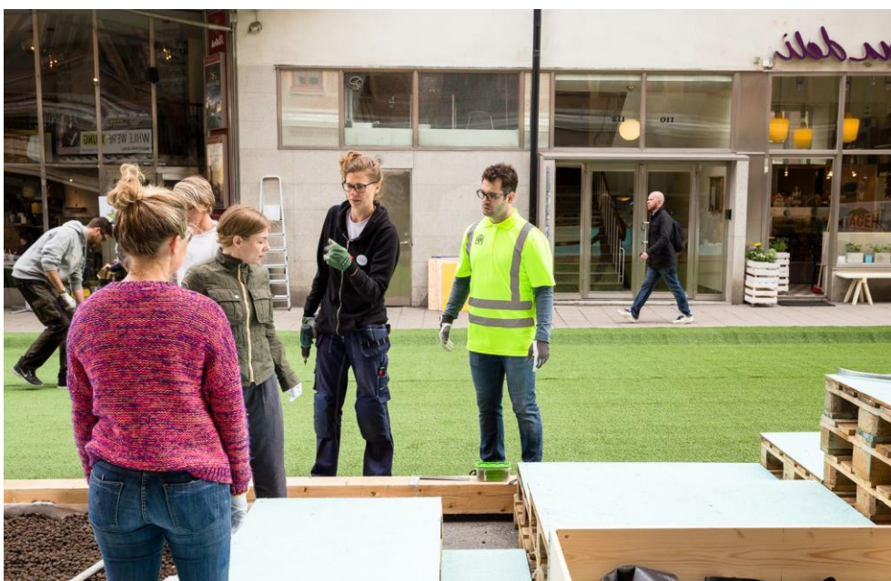
Figur 2-3 Bild från byggandet av Pallis i Stockholm 2015. Källa: Fastighetsägarna och White arkitekter, 2016.
